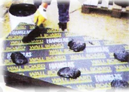
■ 3. Нанесение клея «пятнами» на плиты из пеностекла
