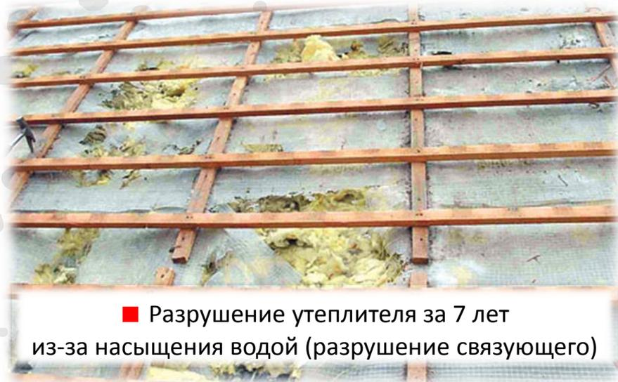
■ Разрушение утеплителя за 7 лет из-за насыщения водой (разрушение связующего)
