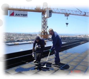
■ 8. Нанесение горячей битумной мастики на блоки из пеностекла
