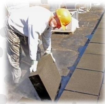
■ 4. Нанесение горячей битумной мастики на боковые поверхности пеностекла.
