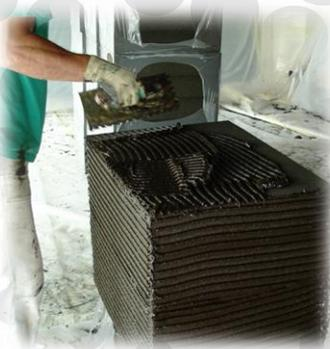
■ 3. Нанесение клея на блоки пеностекла
