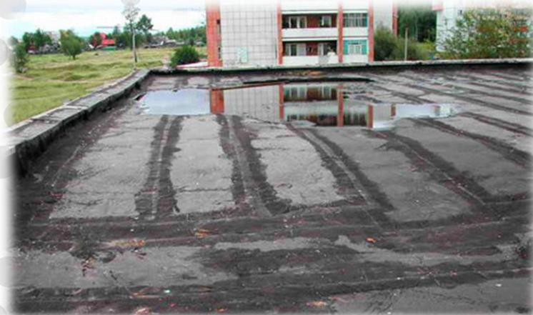
■ Потеря жесткости утеплителя, нарушение гидроизоляции
