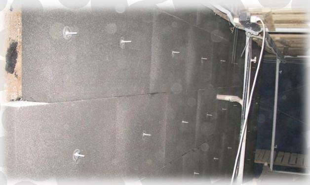
■ 7. Установка анкеров для крепления металлической оцинкованной сварной сетки
