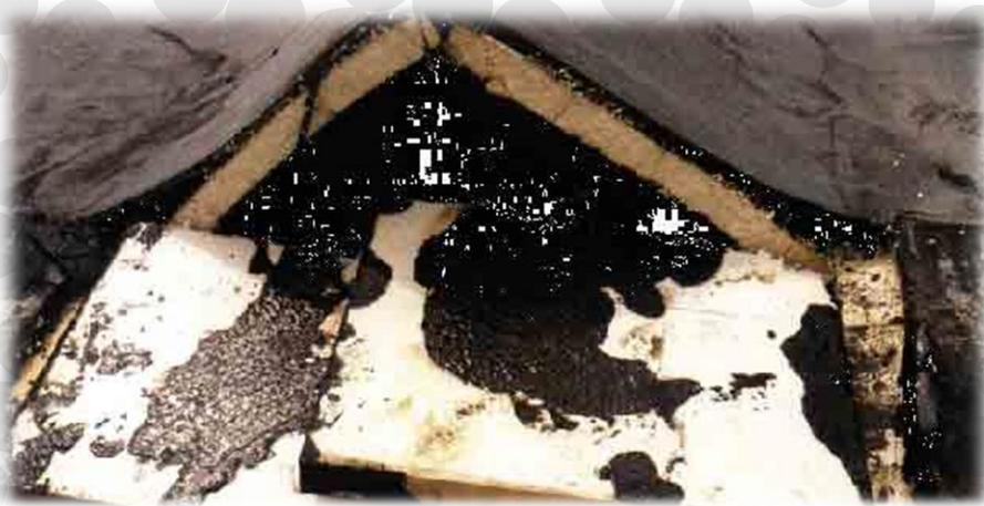
■ Деформация ЭППС, нарушение гидроизоляции вследствие термического расширения ЭППС
