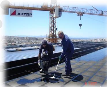
■ 8. Нанесение горячей битумной мастики на блоки из пеностекла
