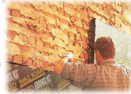
■ 4. Приклейка плит из пеностекла к стене с герметизацией стыков
