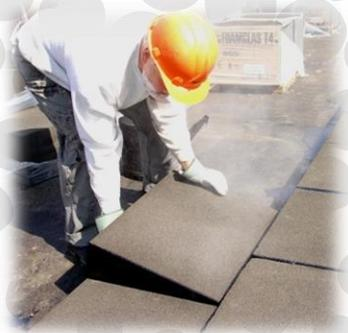
■ 5. Блок из пеностекла укладывают на основание кровли и плотно прижимают к уже уложенным блокам. Все швы должны быть заполнены мастикой. Шов не более 2 мм.
