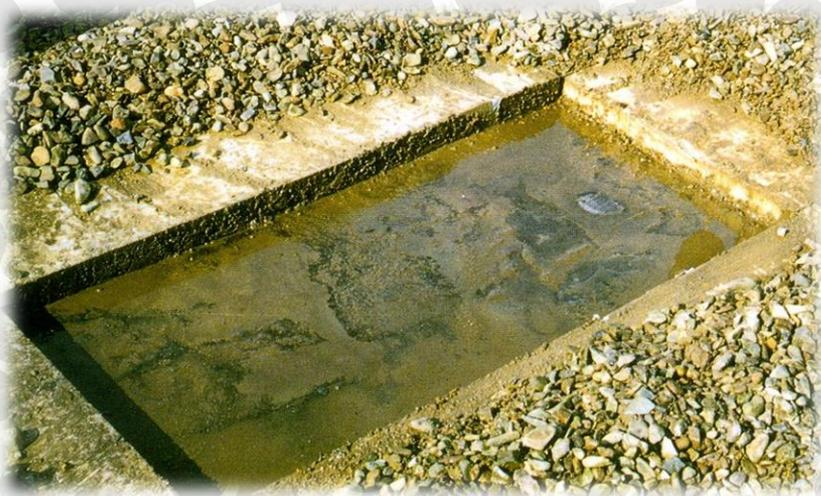
Закрашенная часть – увлажненный утеплитель вследствие образования конденсата:
