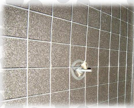
■ 8. Крепление металлической оцинкованной сварной сетки
