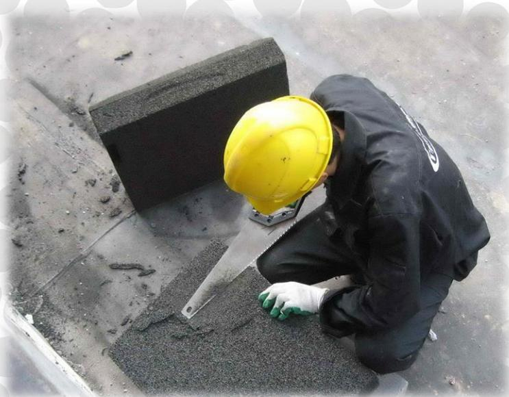
■ Блок легко обрабатывается обычной ножовкой по дереву
