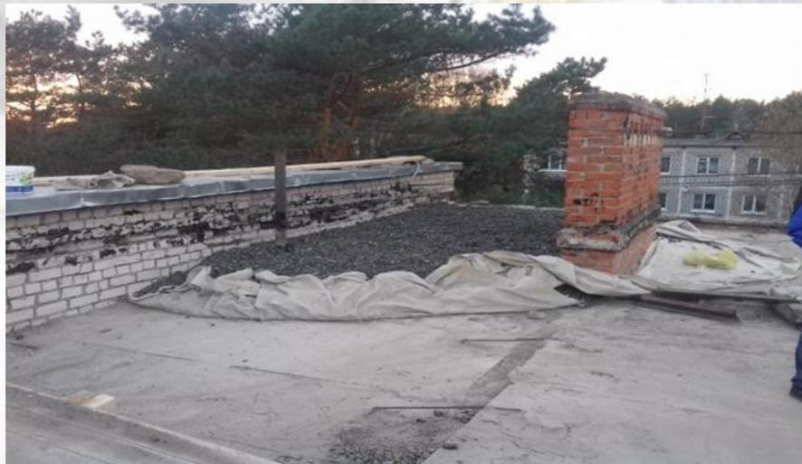
Применение пеностекла в качестве теплоизоляции плоских и чердачных кровель при проведении капитальных ремонтов многоквартирных домов обеспечивает:
