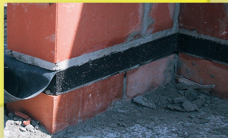
Создание замкнутого теплоизоляционного контура (кирпичная стена на слое пеностекла)
