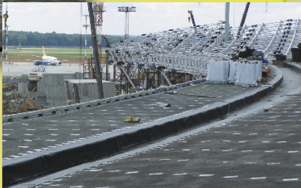
Кровля международного аэропорта «Внуково», г. Москва
