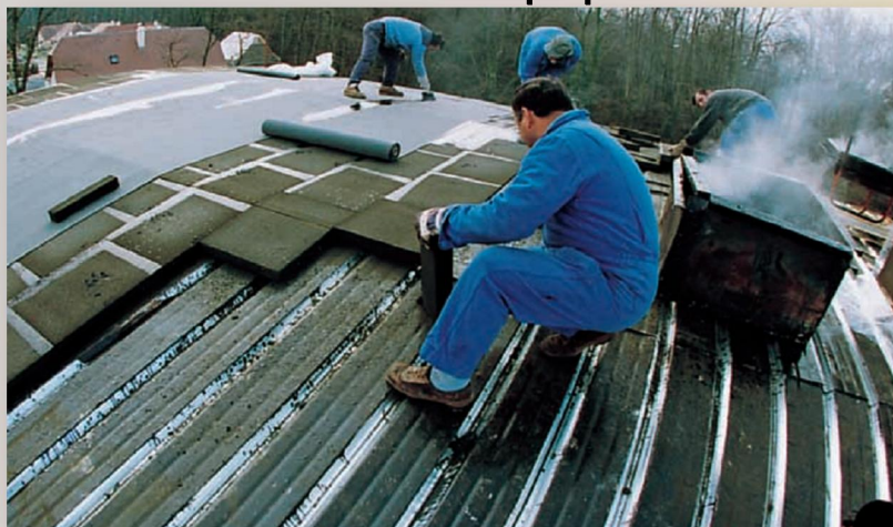
Теплоизоляция кровли, в том числе со сложным профилем
