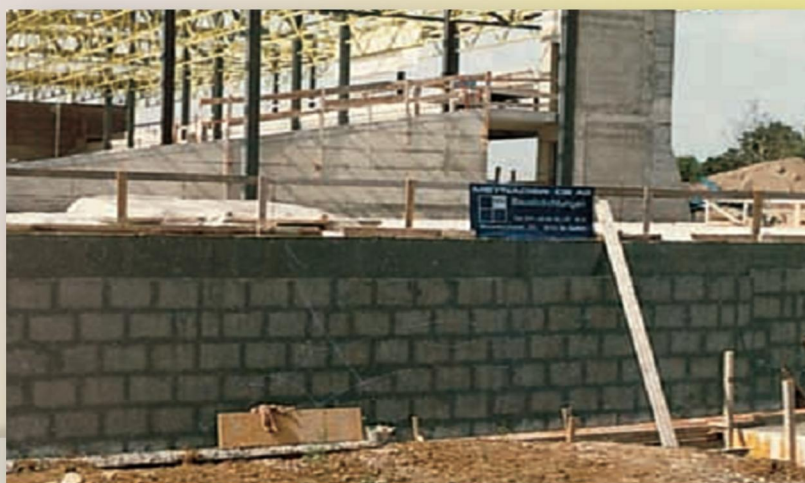
Теплоизоляция стен подвала
